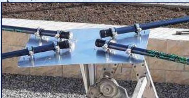
Особый интерес вызывает узел крепления дюралевой пластины к мачте. Для этого использованы 4 шт металлических кронштейнов для настенных полочек.
